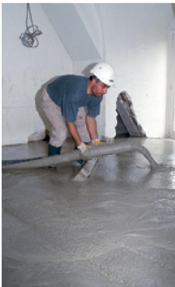
Agilia Horizontal est un béton autonivelant destiné à la réalisation de dallages ou de planchers de bâtiments.
